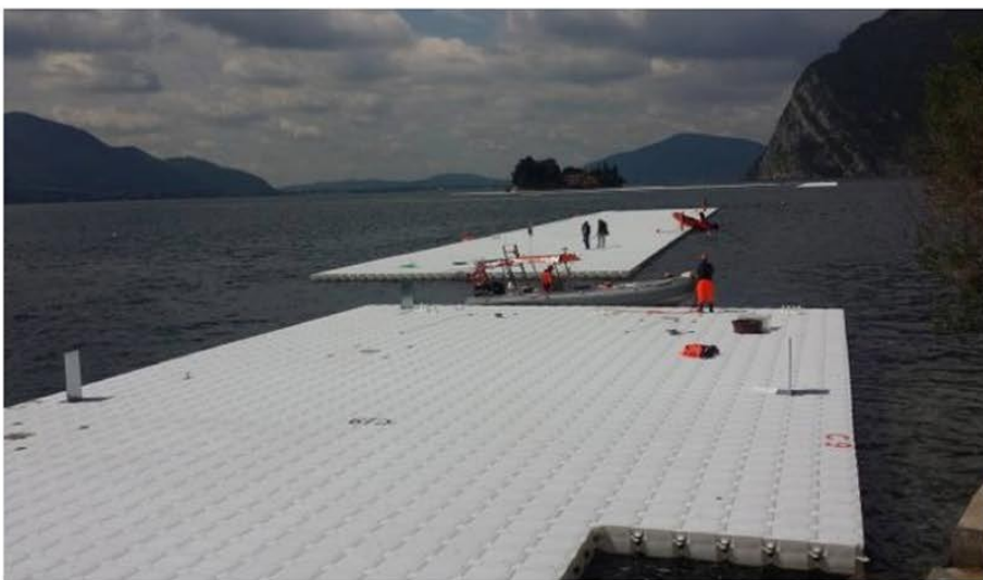
Ecco uno scatto presso il cantiere di Monte Isola
